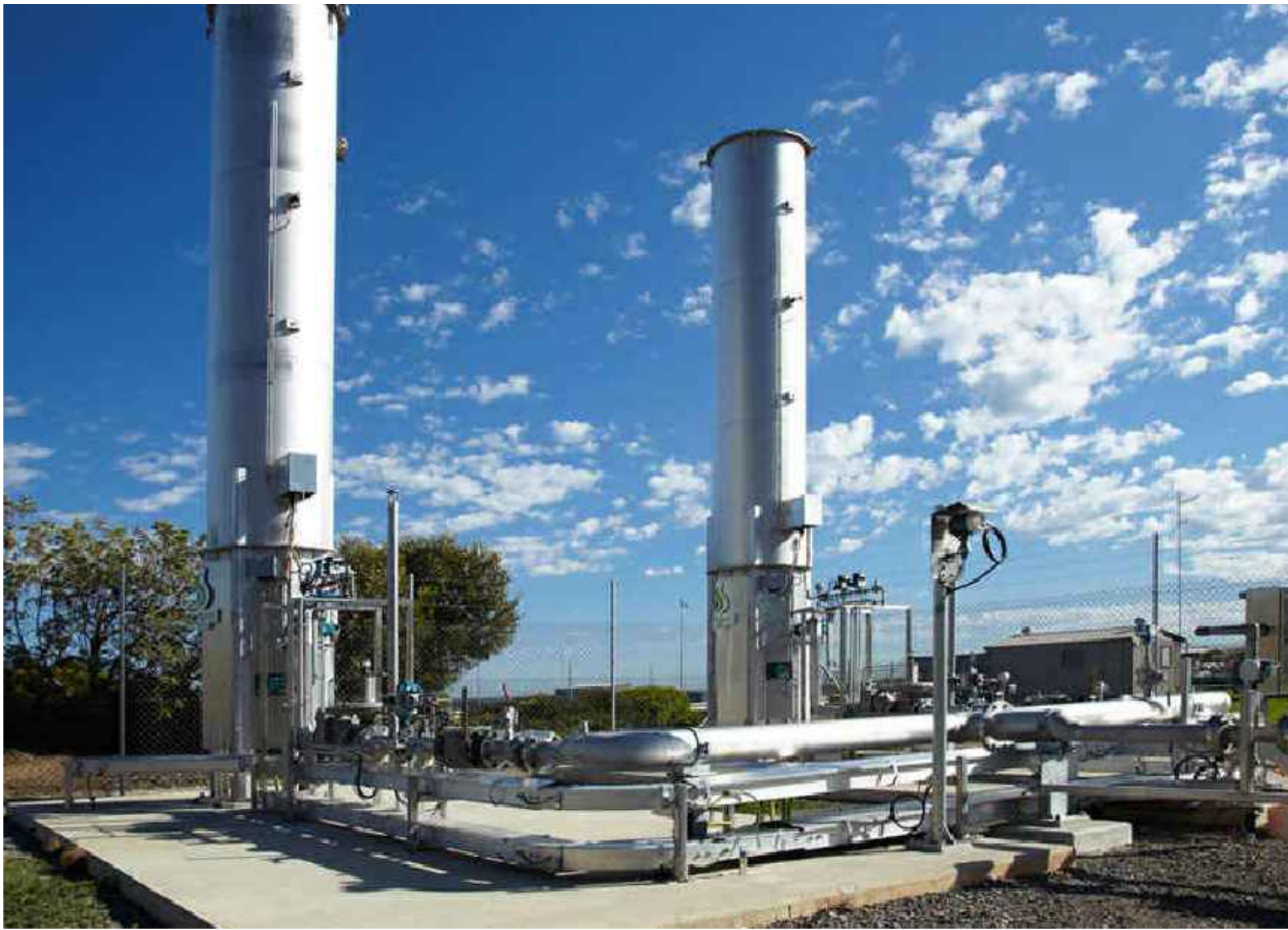
TYPICAL GAS FLARE (N.T.S.)
